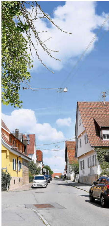
Der nördliche Teil der Burgstraße steht ab Oktober im Fokus der Baumaßnahmen in der „Historischen Mitte Echterdingen“.
